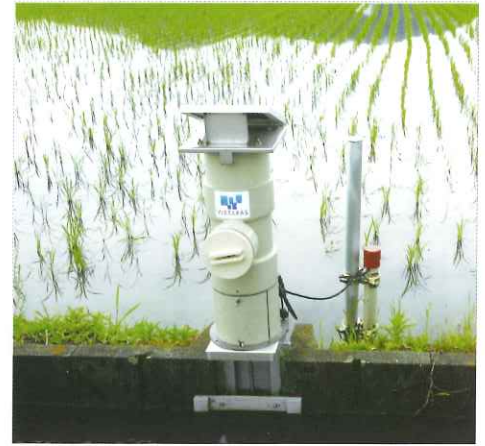
図 11 自動給水栓の設置の様子
